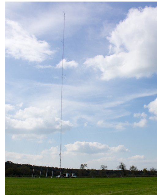
Exemple de mât de mesure
