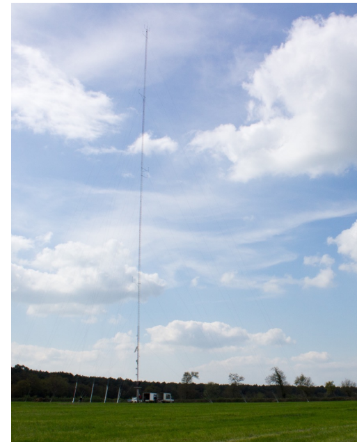
Exemple mât de mesure
